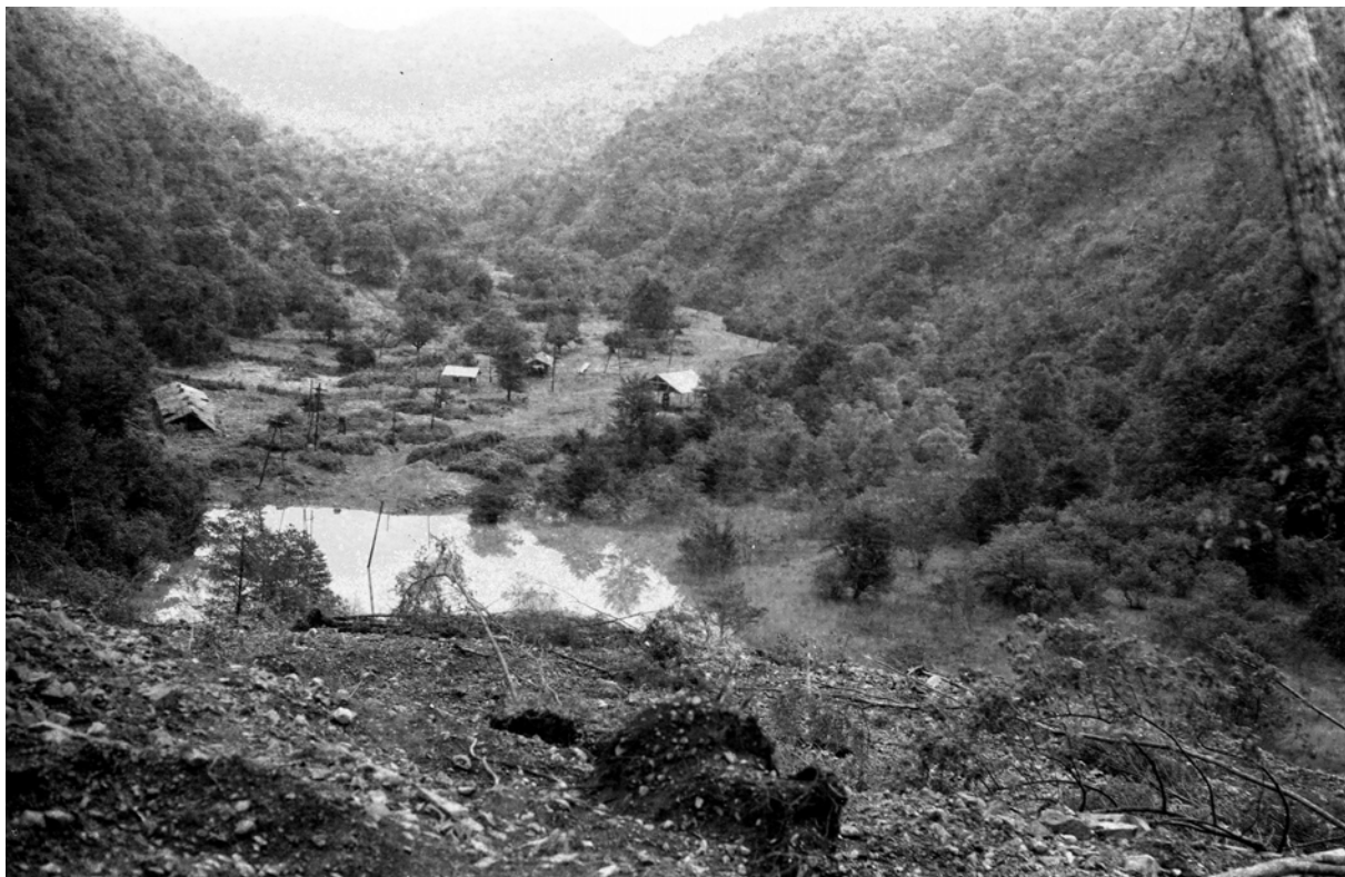
Рис. 10. Разрушения в долине р. Квирила, возникшие при Рачинском землетрясении, начало июня 1991 г. Направление съемки на восток, в верховья долины. В ближней зоне снимка – тело каменной лавины, далее видно небольшое озеро, опоры линии ЛЭП и хозяйственные постройки селения Тбети. Фото Ф.Л. Яковлева.
